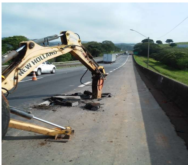
Figura 1 - Remoção da camada de concreto asfáltico
