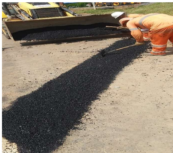
Figura 10 - Distribuição do concreto asfáltico
