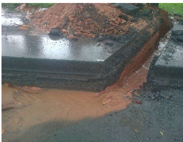
(i) Fechamento e fresagem com fresadora na cota de interesse
