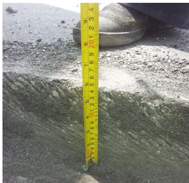
(ii) Controle da espessura de corte
