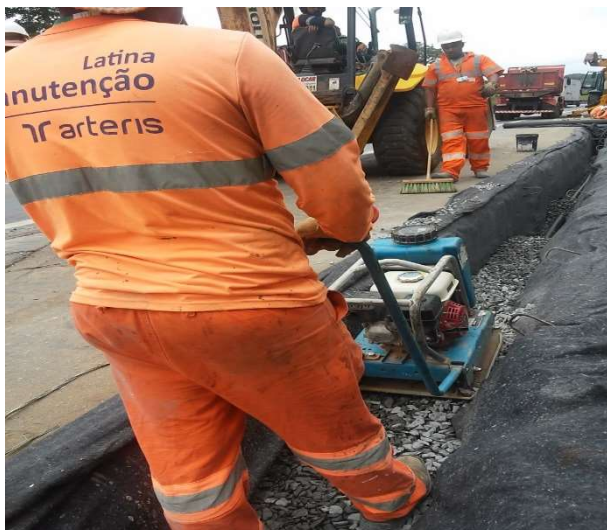
Figura 5 - Compactação da camada drenante
