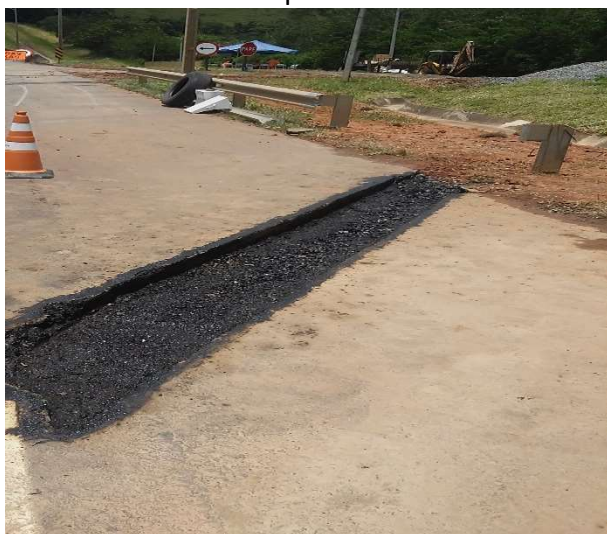
Figura 9 - BGS imprimada
