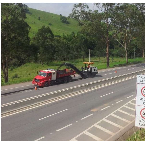
(i) Fechamento e fresagem com fresadora na cota de interesse
