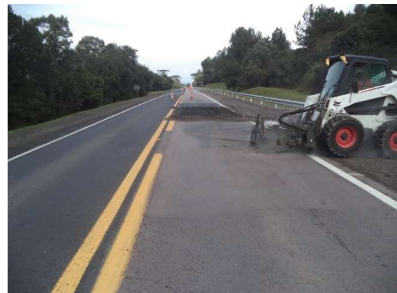
(b) Fresagem com mini fresa
