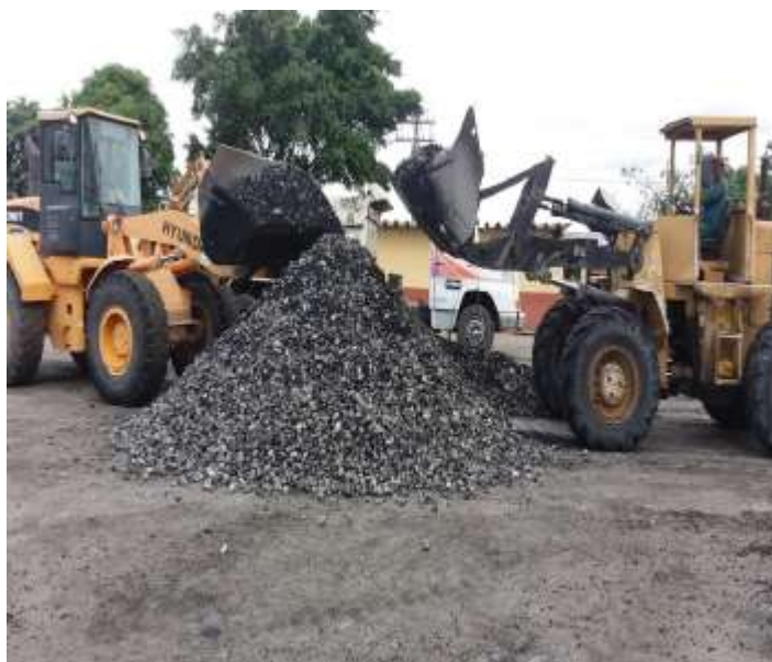
Figura 5 – Homogeneização da mistura
