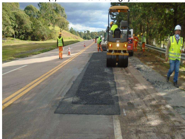
(e) Compactação do remendo
