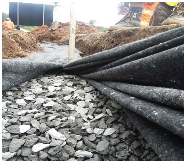
Figura 6 - Fechamento da manta com transpasse total
