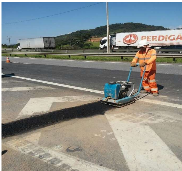
Figura 11 - Compactação da camada de concreto asfáltico
