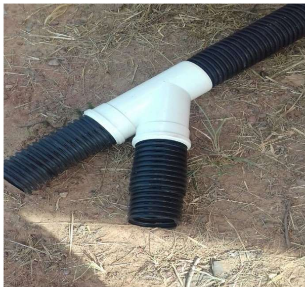
Figura 12 - Detalhe da conexão tipo Y
