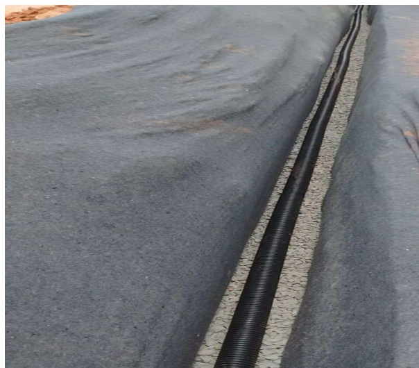
Figura 16 - Emenda do tubo de topo
