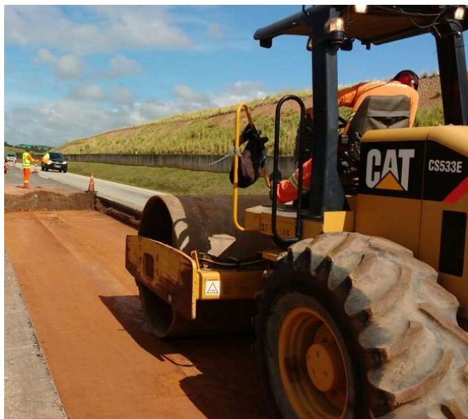
Figura 7 – Selando o subleito
