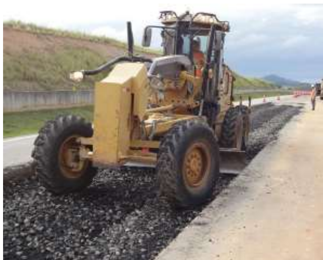
Figura 9 – Nivelamento da camada
