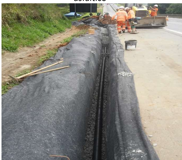
Figura 3 - Posicionamento do tubo na vala
