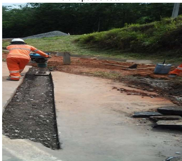
Figura 8 - Compactação da BGS
