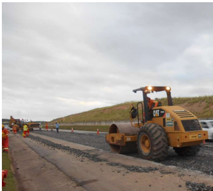
Figura 11 – Conformação da superfície
