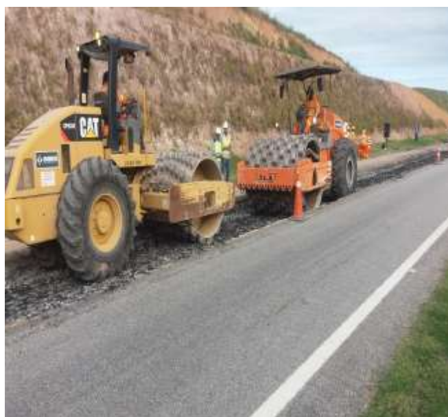
Figura 10 – Compactação da 1 camada
