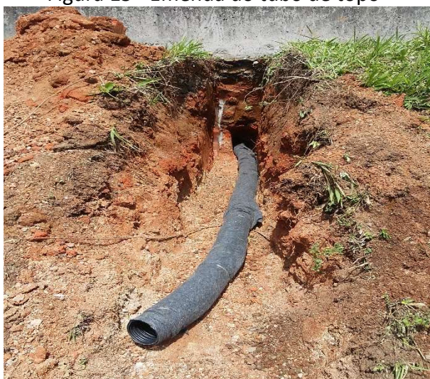
Figura 17 - saída da sangria envolvida com a manta
