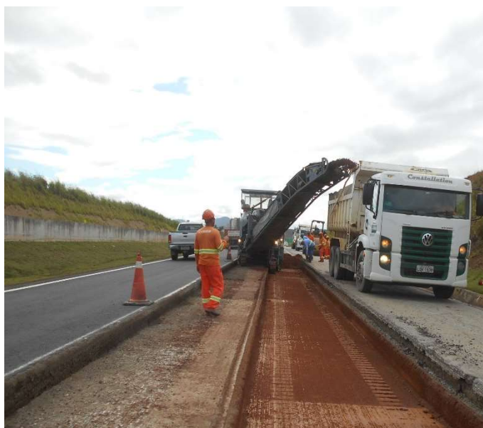
Figura 6 – Fresagem da base / sub-base
