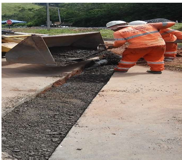
Figura 7 - Espalhamento da BGS com 15 cm de espessura
