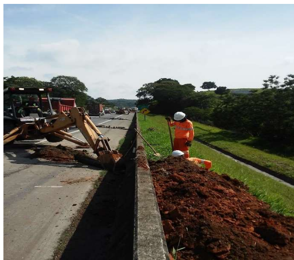
Figura 2 - Escavação da vala
